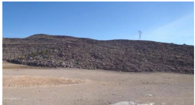
Restauración banco Tn/353 de la zona de la ampliación de la cantera. Se ha realizado la morfología y el aporte de tierra vegetal proveniente de zonas de explotación de la cantera - planta de Monjos (Barcelona)
